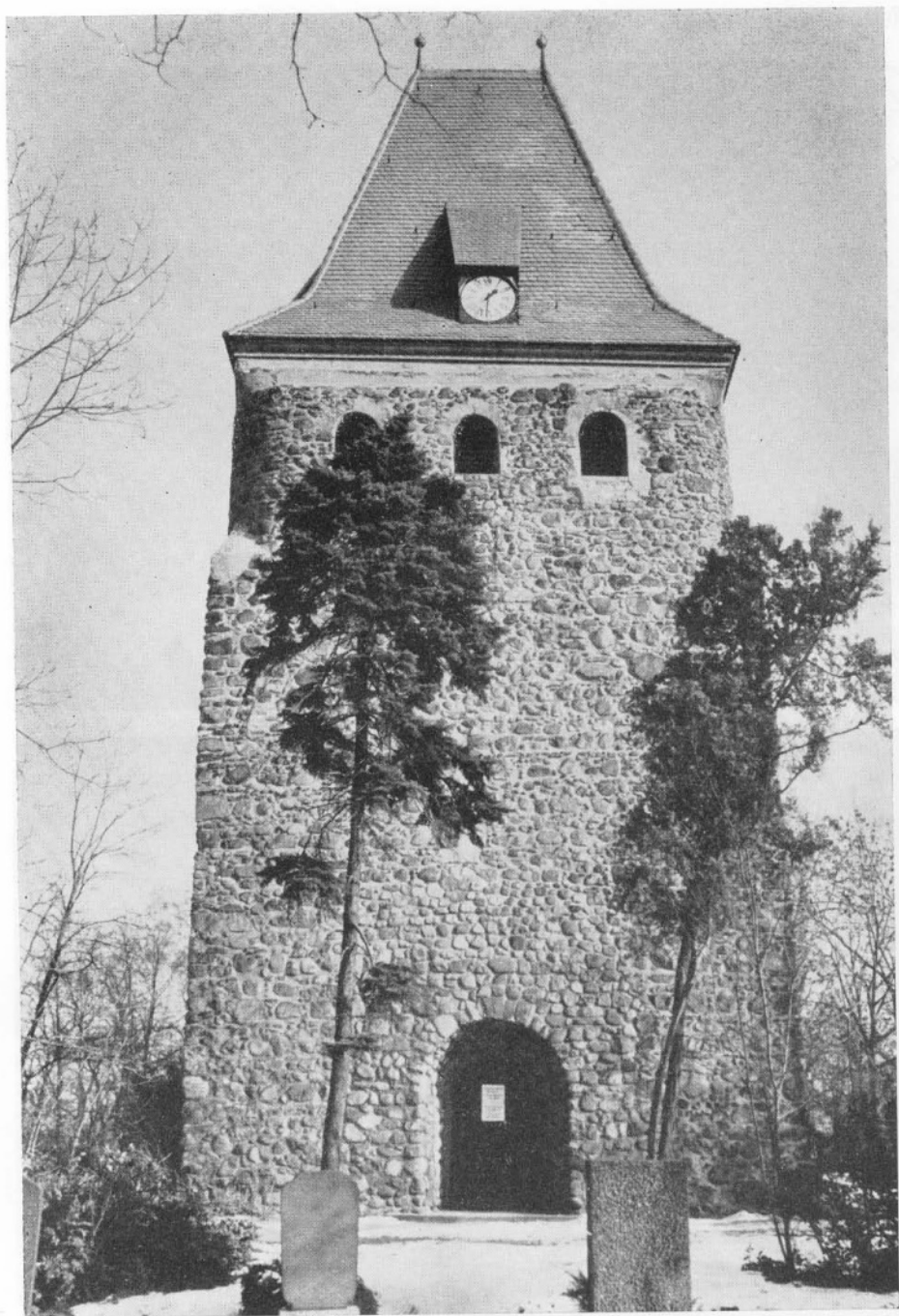
Abb. 9. Mauerwerk der Romanik aus Eiszeitgeschieben, die vielfach windbeschliffen sind und sich damit als „Lesesteine“ zu erkennen geben. Kirche in Leipzig-Thekla.
