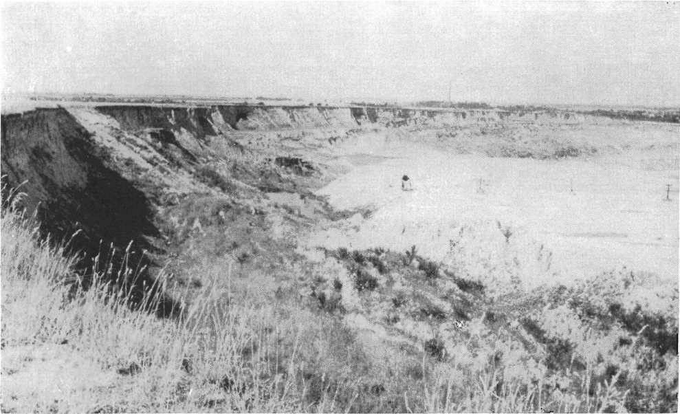
Abb. 1. Staffelbrüche am Altpoderschauer Hang im Tagebaurestloch Zechau, Kr. Altenburg. Zustand 1959 kurz nach dem Ende des Förderbetriebes und vor der Wiederurbarmachung. Foto: M. NAUNDORF [10]
