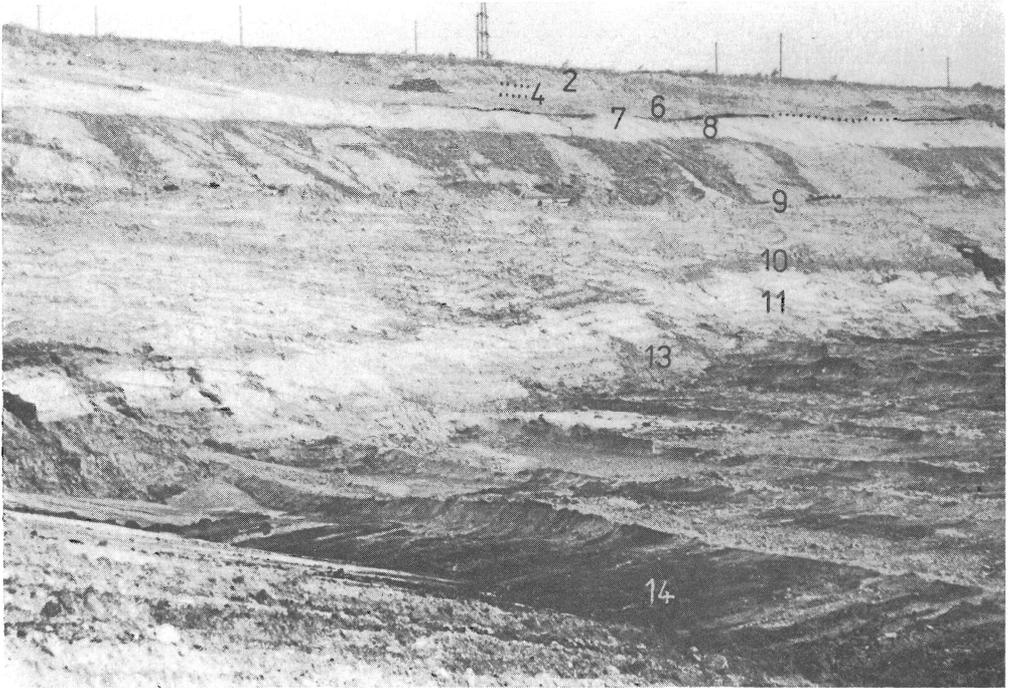
Bild 1. Übersicht der Schichtenfolge des Tagebaues Miltitz. Nordweststoß der Endstellung um 1960. Numerierung der Schichten wie auf Abb. 2, S. 220
