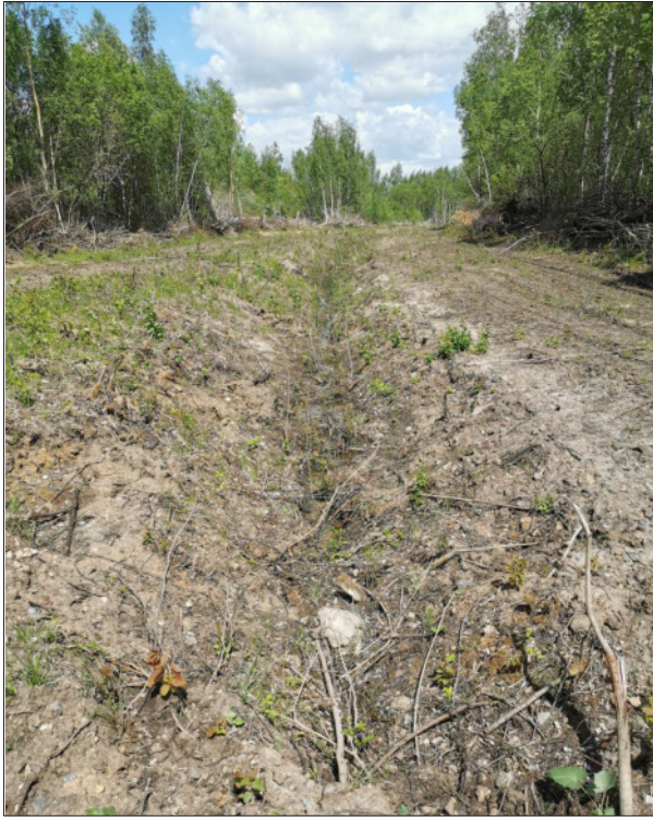
Abb. 58: Trockenfallender verschlossener Abflussgraben des Restlochgewässerüberlaufes bei der Artenhilfsmaßnahme im Falkenhainer Kessel im Sommer, 28.05.2020. (Foto: S. Rockstroh)
