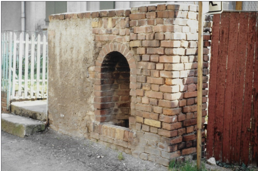
Abb. 2: Baustil der meisten artesischen Brunnen in Bad Döben mit typischer Nischenform (eingelassene Halbmondnische) in einem aus Ziegelstein errichtetem Quader. (Foto: R. Zenger)
