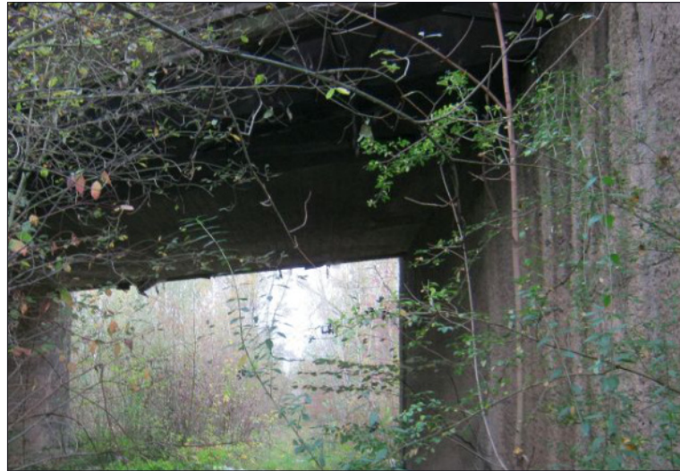
Abb. 114: Verbindung der nördlichen und südlichen Fläche des Beweidungsgebietes am ehemaligen Kraftwerksstandort Mumsdorf durch eine Straßenunterführung, 27.10.2017. (Foto: S. Rockstroh)
