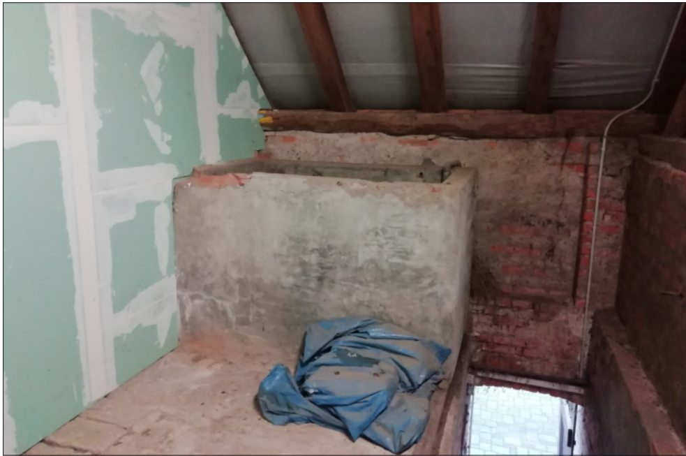
Abb. 4: Bäuerliche Zisterne in einem alten Bauernhof in Oberglaucha, unten rechts der Eingang zur Obertenne. (Foto: R. Zenger)
