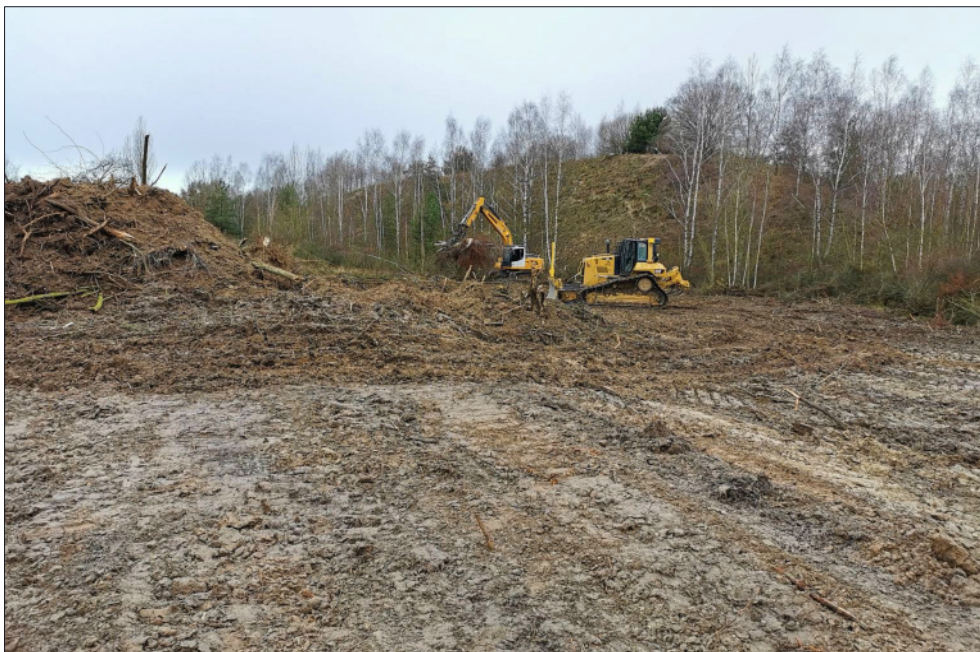
Abb. 6: Gehölzentnahme von Sukzessionsflächen und Wiederherstellen von Rohböden mit Planierraupe und Kettenbagger auf dem trockenen Mittelkippenplateau, 26.02.2020. (Foto: S. Rockstroh)
