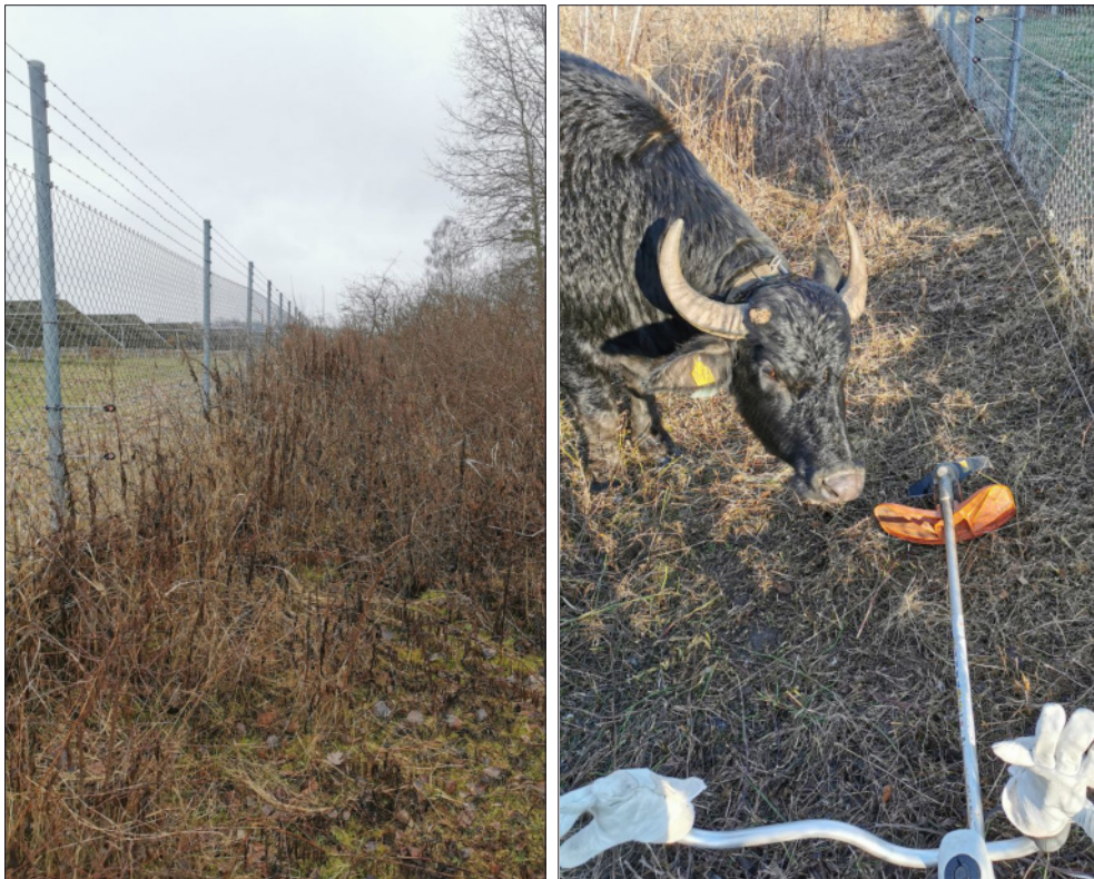
Abbn. 136 und 137: Vierzügiger Elektrozaun mit Abstandshaltern am Maschendrahtzaun der Solaranlage vor und nach dem Freistellen von Vegetation, 08.02.2024 und 21.01.2022. (Fotos: S. Rockstroh)
