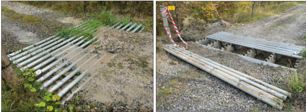
Abbn. 138 und 139: Gefüllter und bewachsener sowie auseinandergebauter und ausgeschauelter Weiderost, 12.10.2021 und 18.10.2021. (Fotos: S. Rockstroh)
