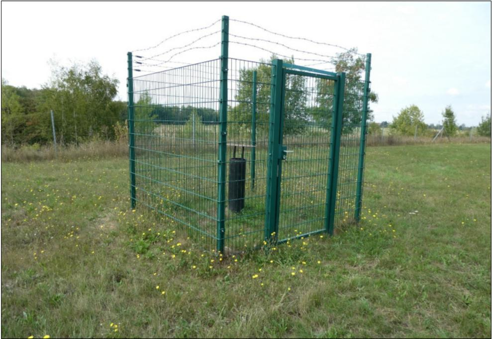
**Abb. 9:** Passiver Entgasungsschacht pES 3 auf der Hyzet-Kippe, 2022.
