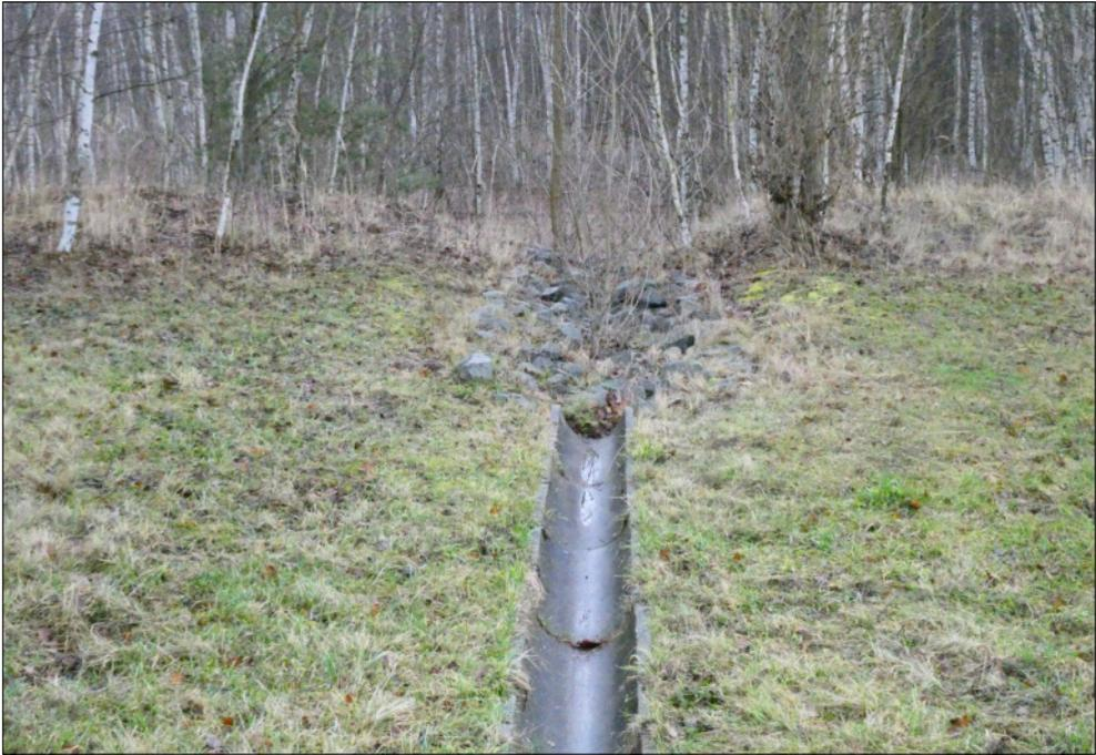
**Abb. 7:** Ableitung von Oberflächenwasser am Böschungsfuß der Hyzet-Kippe, 2022.
