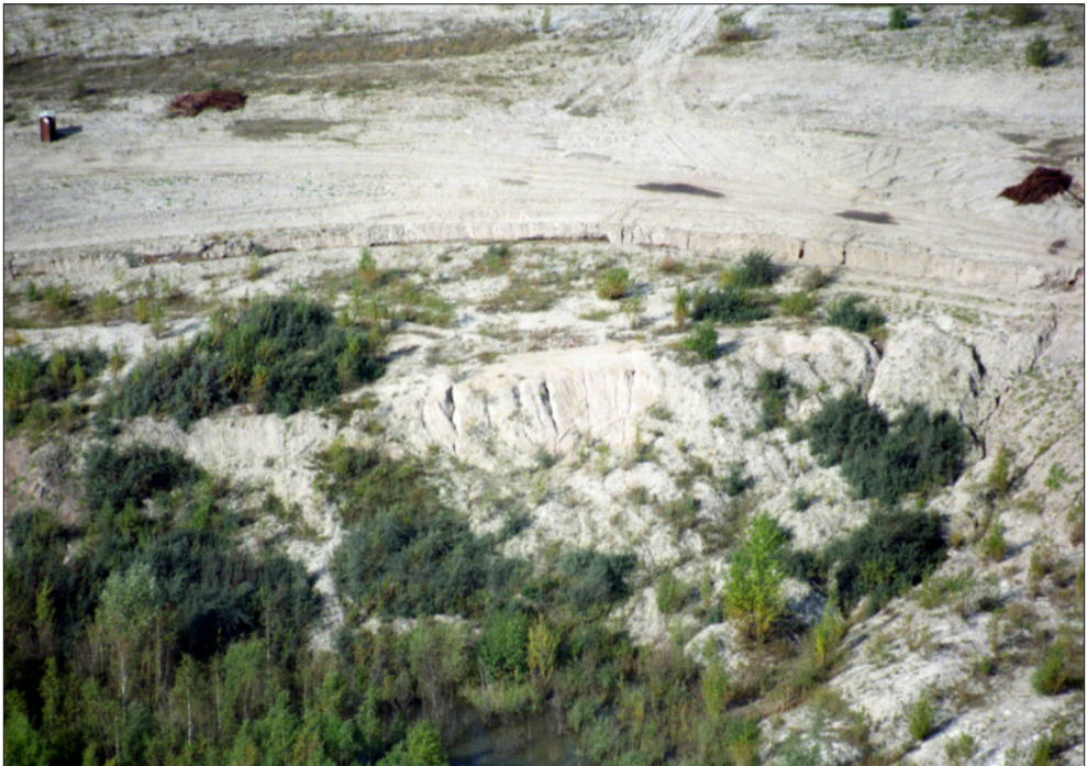
Abb. 9: Trotz Abflachung der Böschungen gibt es noch Bereiche, in denen Erosion erfolgen kann, 12. September 1995.
