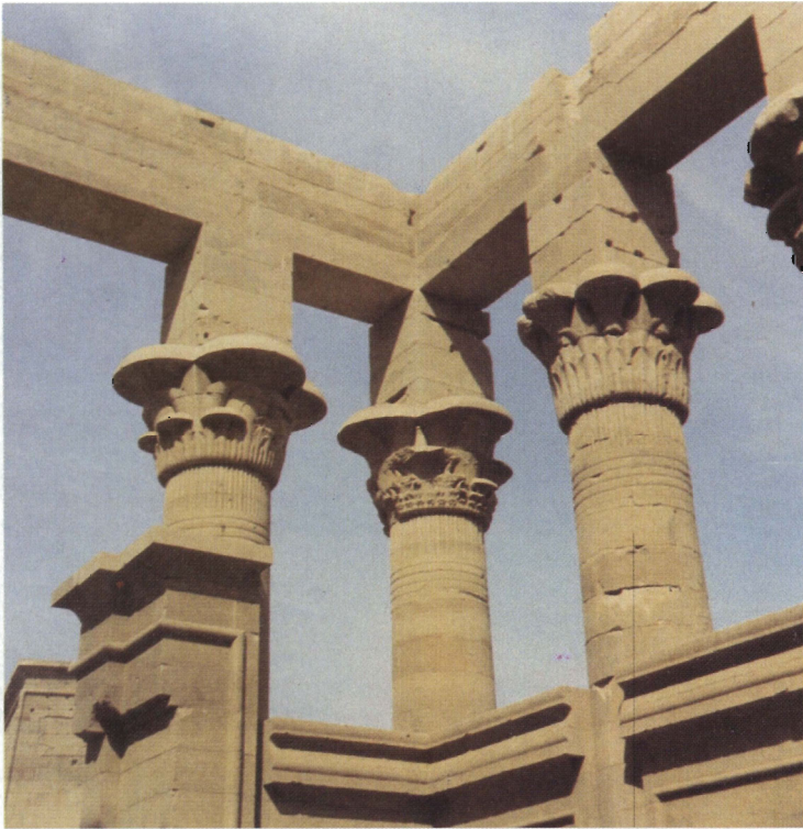
Abb. 7. Säulenkapitelle an TRAJANS Kiosk nach der Umsetzung, Blick von innen nach NW. Foto 1984 von SOFIE RÖMER
