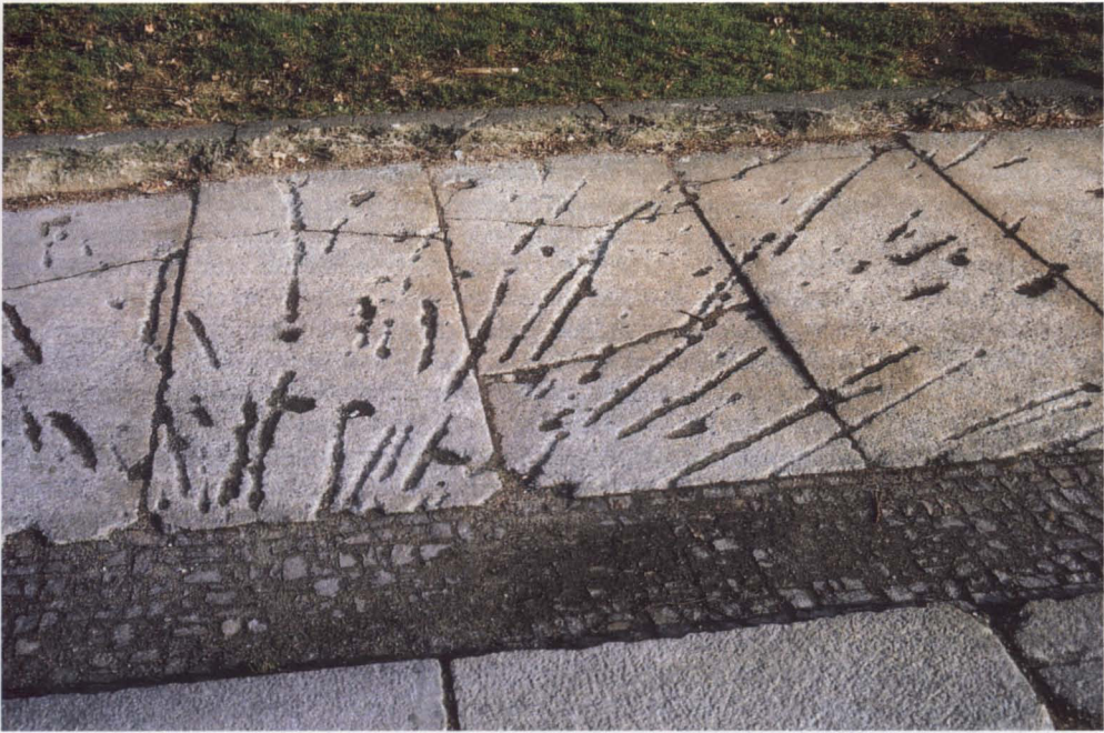
Abb. 3. Splitterfurchen (Ausschnitt) auf den Gehwegplatten aus Lausitzer Granodiorit („Granit“) unweit der östlichen Ecke Wilhelm-Seyfferth-Straße/Beethovenstraße in Leipzig. Foto: 1. 1. 1998
