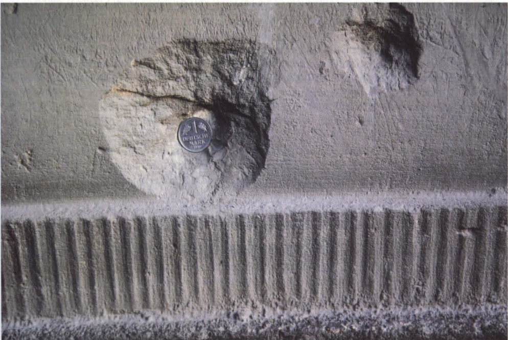
Abb. 4. Kraterartige Einschlagsmarken von Bombensplintern in der Sandsteinfassade auf der Westseite des Reichsgerichts in Leipzig. Foto: 1. 1. 1998
