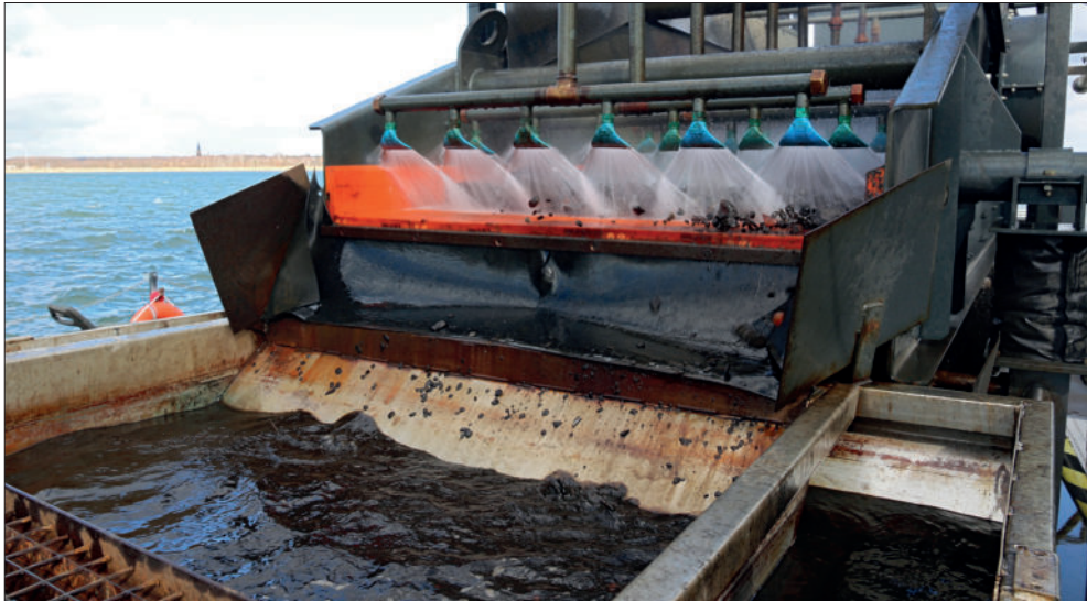
Abb. 10: Detail der Aufbereitungsanlage: Wasserstrahlen trennen feines Sedimentmaterial ab. Die Grobbestandteile gelangen in eine Wanne mit Salzwasser (Foto: I. Rappsilber).
