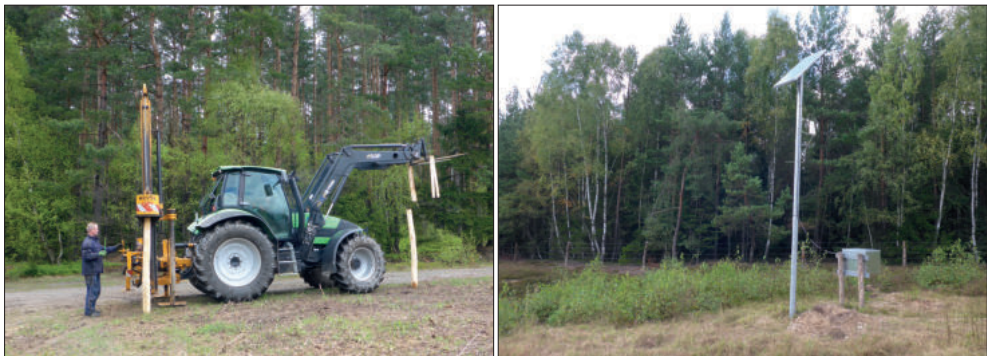
Abb. 22: Im Mai 2017 begannen die Zaunbauarbeiten auf der Lehrgrenze mit dem Rammen der Robinienpfähle. Der Zaun wird über ein Solarmodul mit Strom versorgt (Fotos: E. Endtmann).
