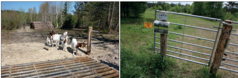
Abb. 23: Dank eingebauter Viehroste erfolgt die Holzabfuhr durch den Sprengmittelplatz hindurch auch bei Tierbesatz reibungslos. Selbstschließende Besuchertore ermöglichen jederzeit die Nutzung bestehender Wanderwege (Fotos: E. Endtmann).
