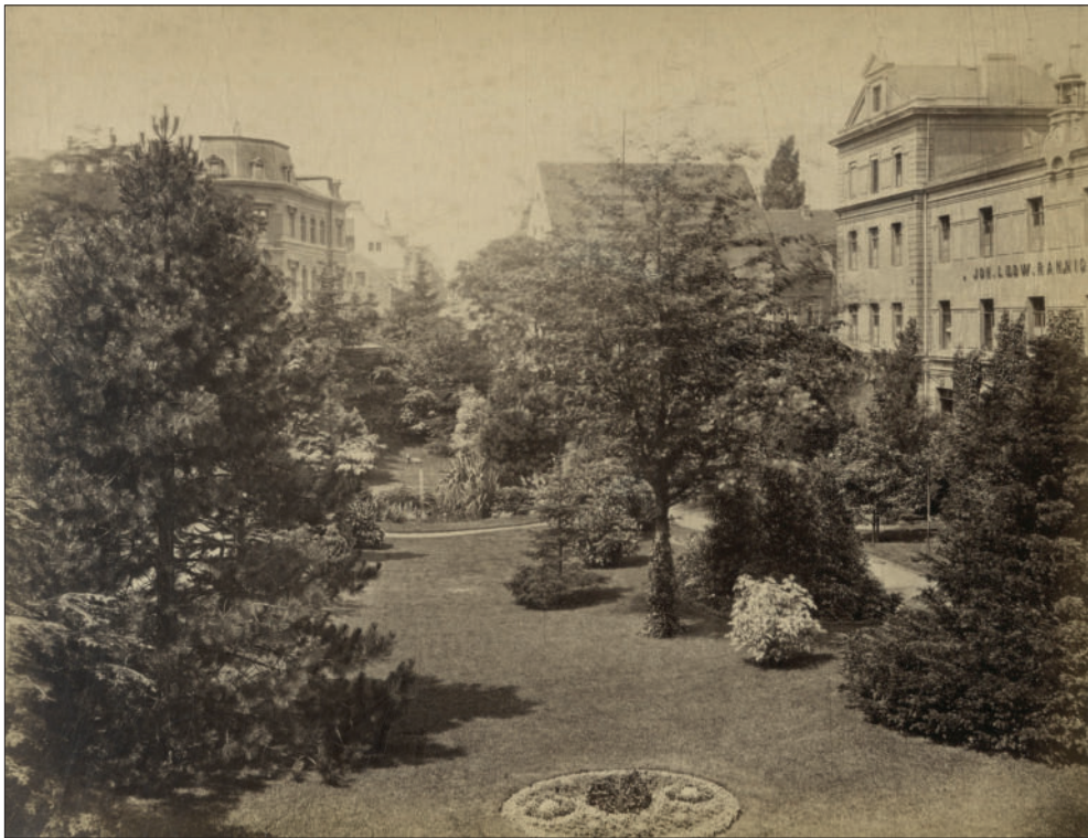
Abb. 52: Blick in den Garten der Familie Ranniger (LATH – StA Altenburg, Bildersammlung, Nr. 560).
