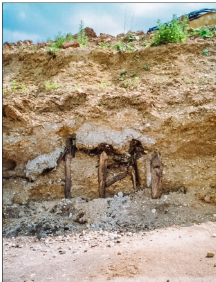
Abb. 9: Eingestürzte Grubenstrecke der Grube „Marie Nr. 340 Aue“ mit frühpleistozäner Kiesfüllung und ca. 2 m mächtigem Hangendkies, östliche Abbauböschung der Tongrube Grana (Foto: H.-J. Bellmann, 2015).
