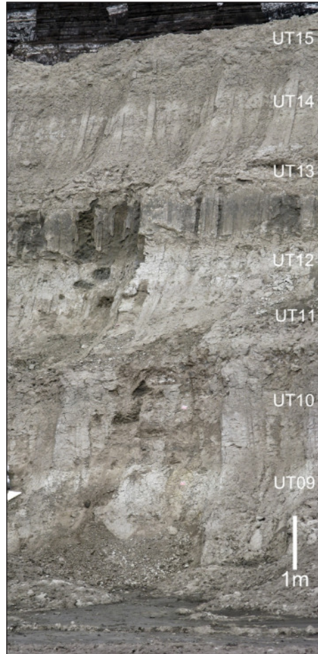
Abb. 21: Profilanschnitt bei Teilprofil 4 mit den Ton-/Schluffbänken UT09–UT15.
