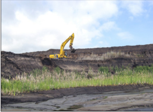
Abb. 11: Freilegung des Basisprofils an der nordwestlichen Tageauböschung.
