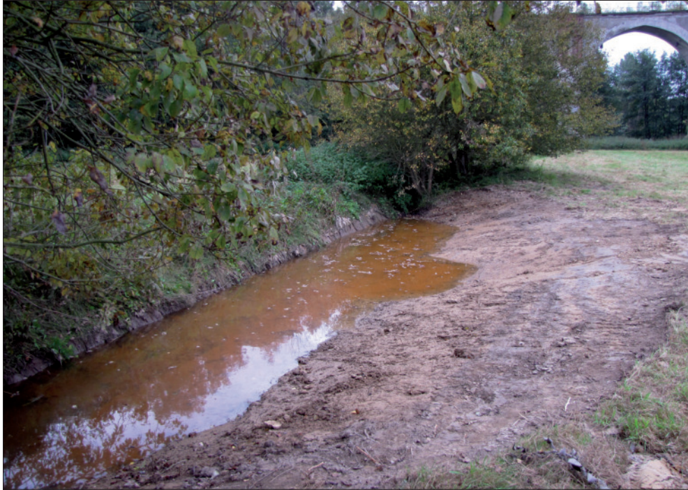
Abb. 35: Die Grabentasche des Entwässerungsgrabens auf der Viaduktweise bei der Bauabnahme im Oktober 2011 (Foto: Mauritianum).
