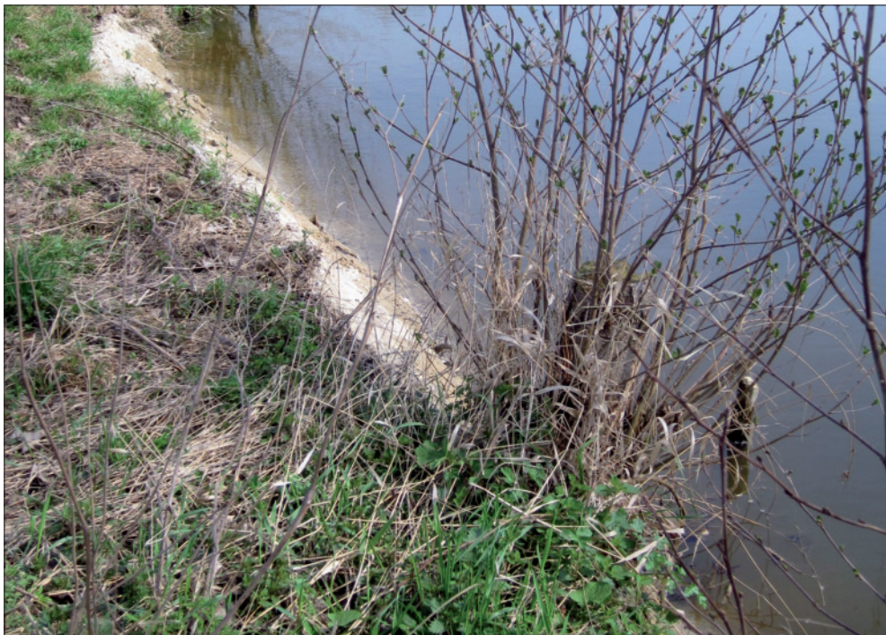
Abb. 53: Westliches Ufer nach der Entnahme der Faschinen und Ufermodellierung mittels Ton-Kies-Abdeckung (Fotos: Mauritianum).
