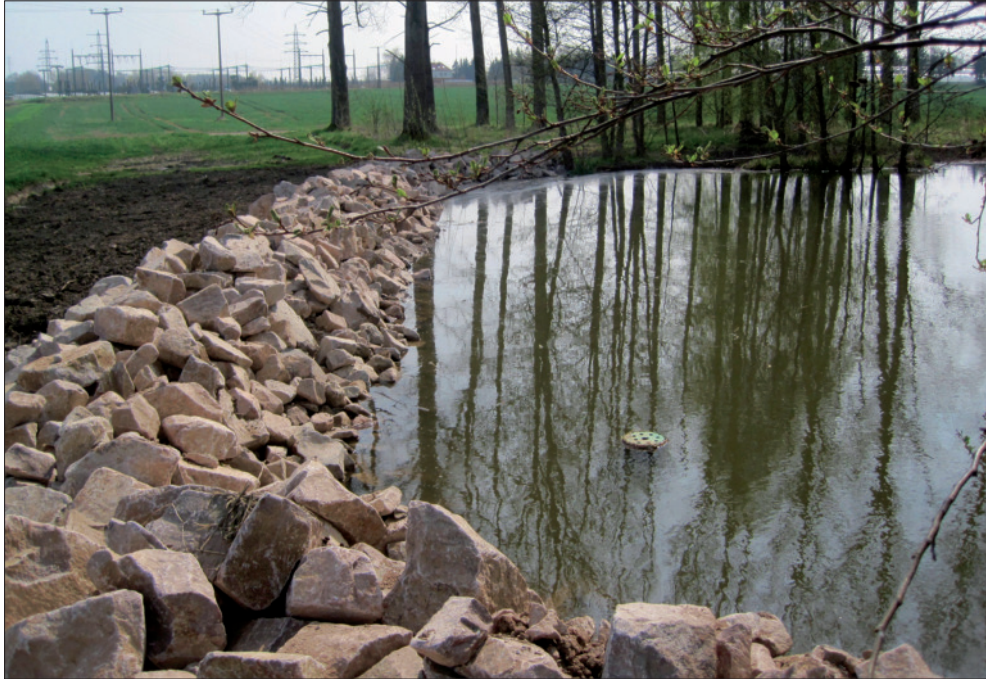
Abb. 55: Nach der Maßnahme: Die Natursteinschüttung am Nordufer dient als Lückensystem-Lebensraum, Bildmitte: der neue Oberflächenablauf (Foto: Mauritianum).
