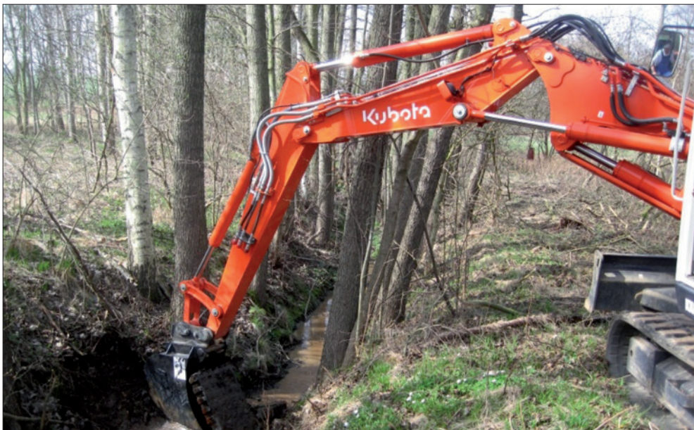
Abb. 62: Entfernung der Wabengitterplatten aus dem Mühlgraben (Foto: Mauritianum).
