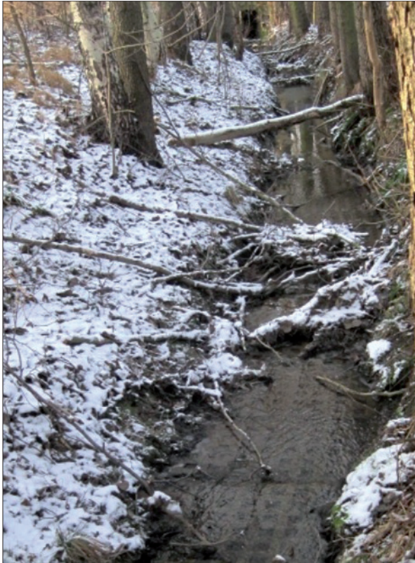
Abb. 61: Der mit Wabenplatten verbaute Mühlgraben vor den Renaturierungsarbeiten (Foto: Mauritianum).
