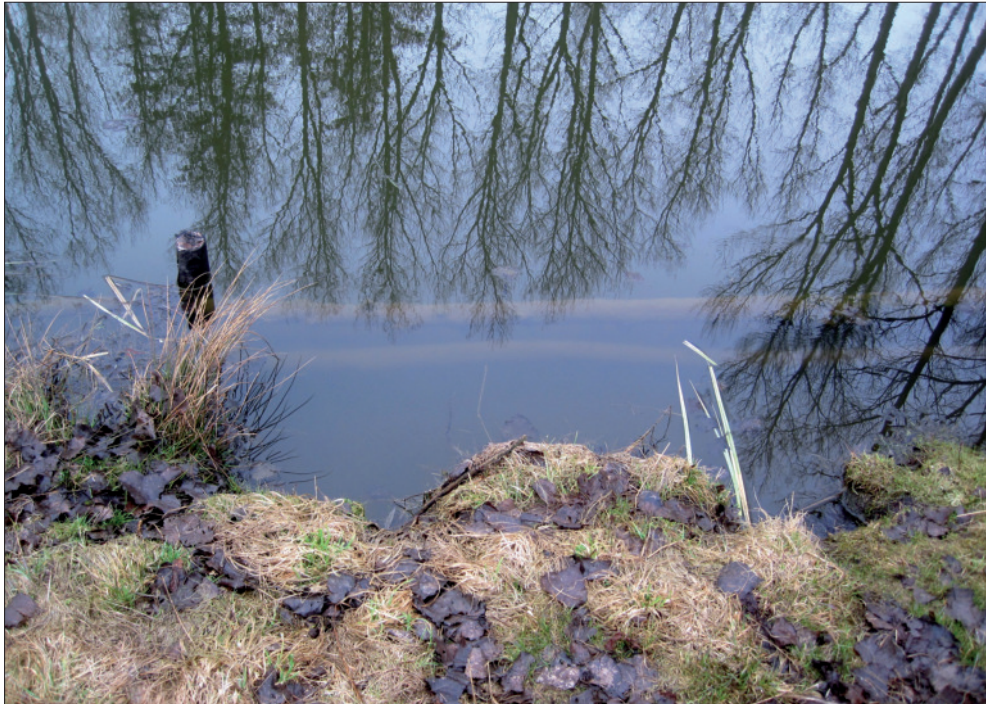
Abb. 52: Ufersicherung durch Holzfaschinen an der westlichen Uferkante vor Maßnahmebeginn.
