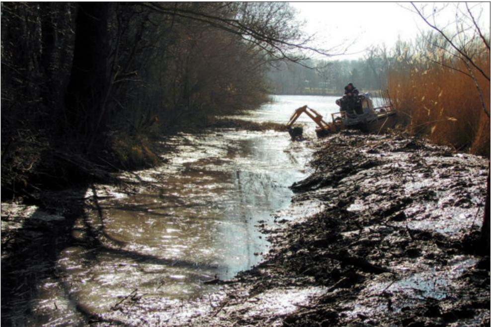
**Abb. 91:** Baggerarbeiten mit dem Amphibienfahrzeug Truxor – ein zur Pflege von Gewässern und Feuchtgebieten geeignetes Verfahren (Foto: A. Borowski).
