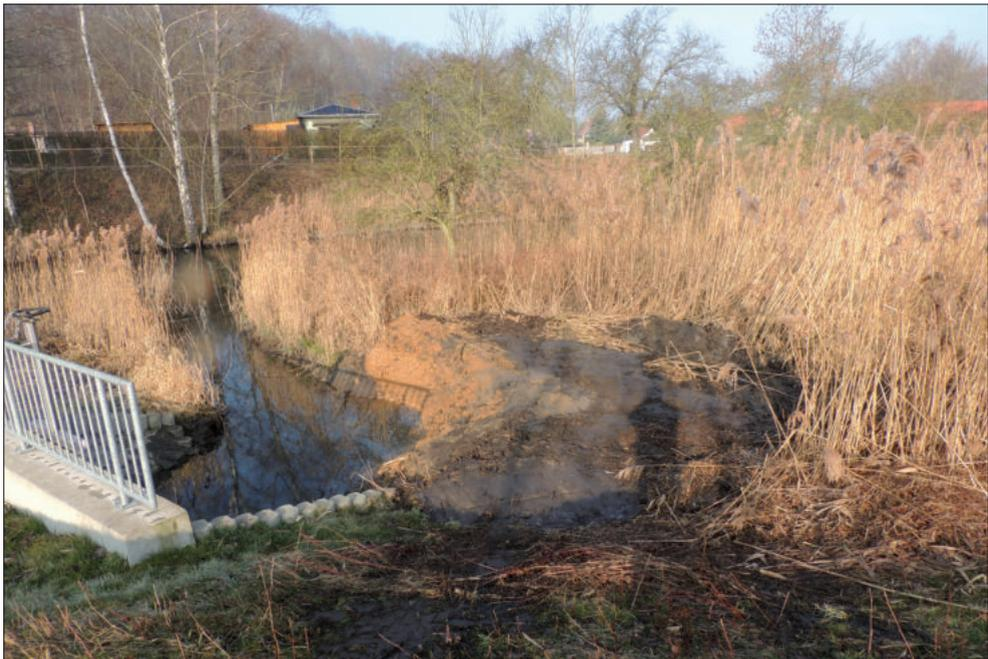
**Abb. 37:** Die Lehmschürze am Siel verhindert den Zulauf durch den Herthateich (Schilffläche rechts) und zwingt das Wasser in den Backhausteich (links; Foto: Mauritianum).
