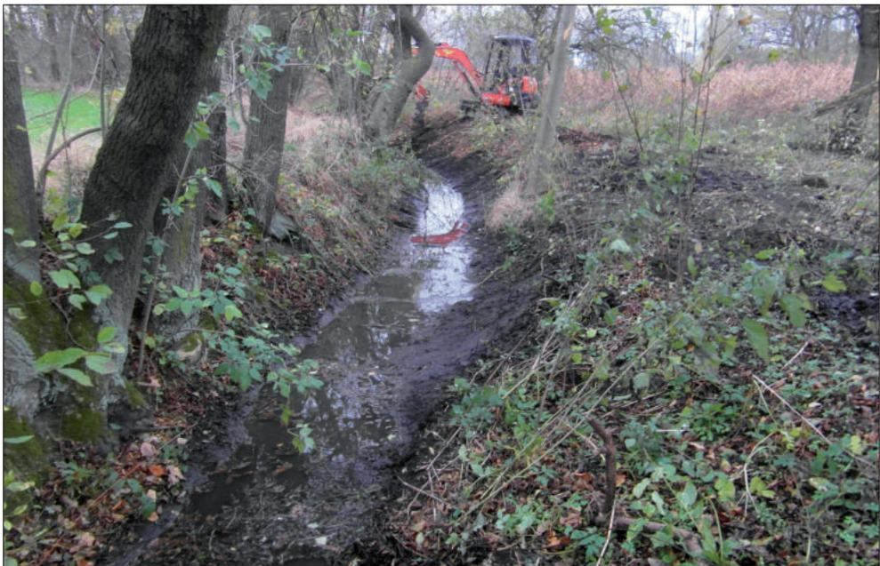
**Abb. 45:** Wiederherstellung des Umlaufgrabens südlich des Fraunteiches (Foto: Mauritanium).
