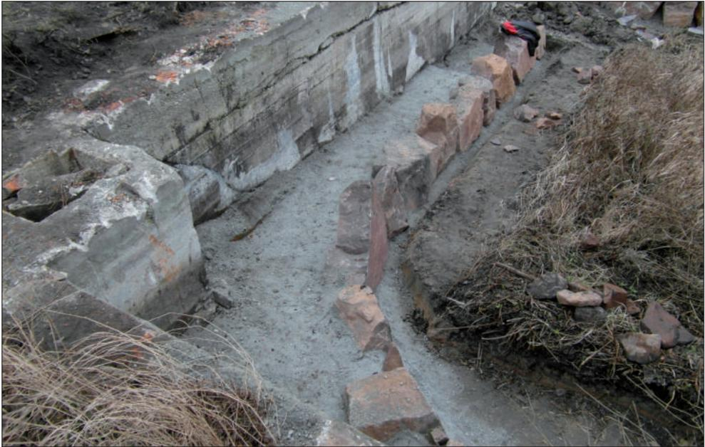
**Abb. 54:** Bereits Anfang Januar 2014 wurde mit den Arbeiten zur Natursteinverblendung (Rhyolith) begonnen, in der zweiten Januarwoche war die Mauergründung im ersten Abschnitt fertiggestellt sowie eine erste Steinreihe in Beton gesetzt (Foto: Mauritanium).
