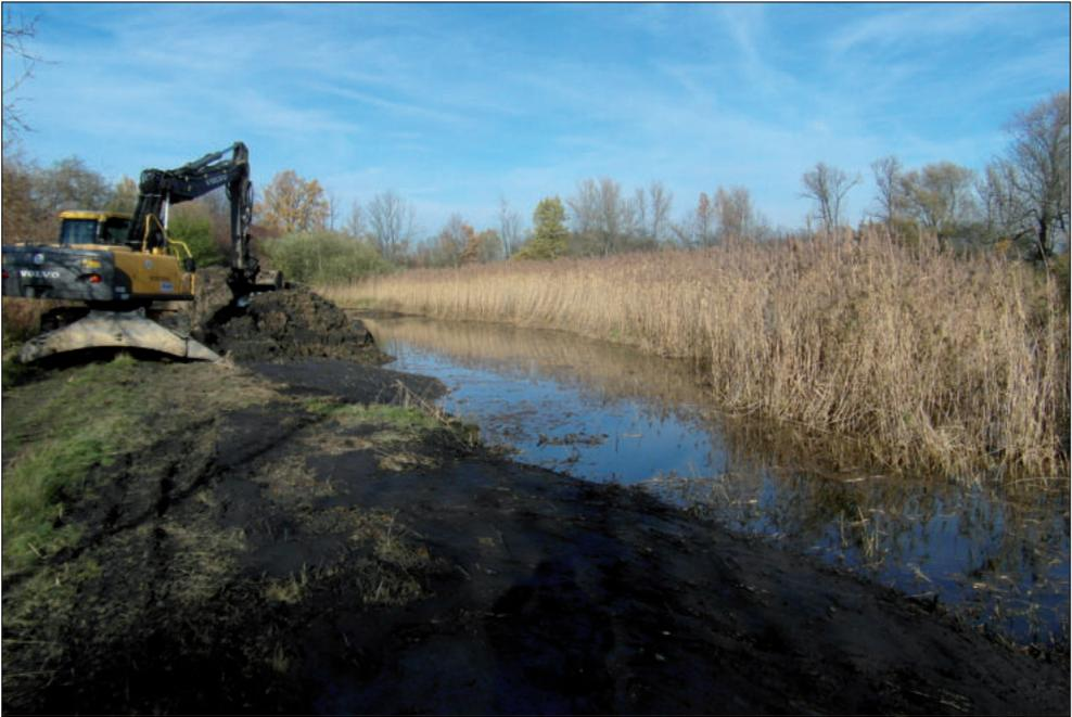
**Abb. 42:** Baufortschritt beim Abtrag von Schilf und Teichschlamm in den Uferzonen des Großen Schirmteiches (Foto: Mauritianum).
