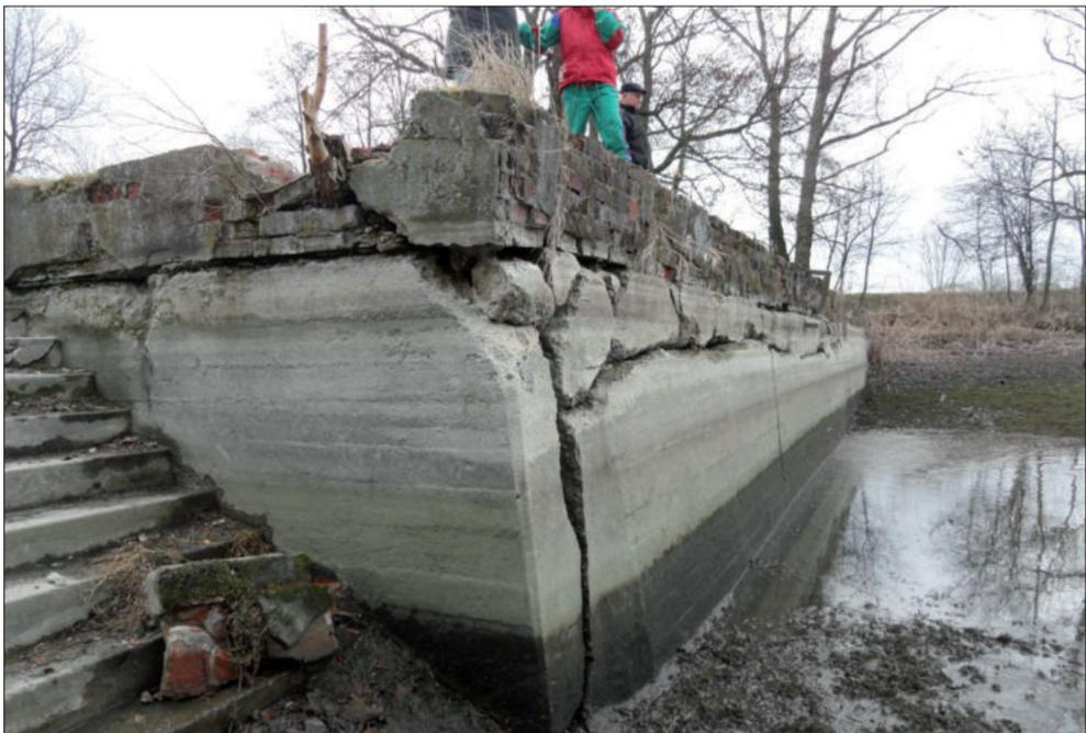
**Abb. 52:** Ansicht der Ufermauer mit integrierter Treppenanlage nach dem Ablassen des Teiches (Foto: Mauritianum).
