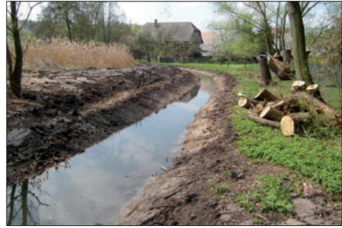
**Abb. 22:** Wiederherstellung des Umlaufgrabens am Rittergutsteich, Mittellauf (links) und Oberverlauf (rechts; Fotos: Mauritianum).
