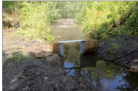
**Abb. 26:** Einbau von Regelbauwerken an Rittergutsteich und Umlaufgraben (Fotos: Mauritianum).
