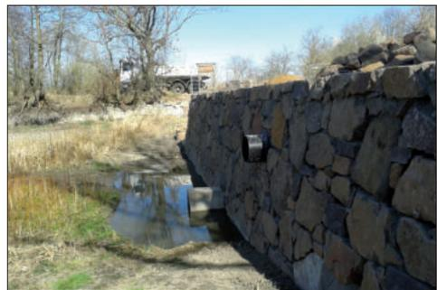
**Abb. 56:** Die neue Ufermauerverblendung mit integrierten Zu- und Abläufen der Hälterteiche (Fotos: Mauritanium).
