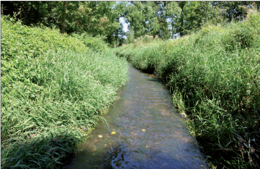
Abb. 6: Renaturierter Blaue Flut-Abschnitt mit mäandrierendem Gewässerverlauf, kiesiger Sohle und einer Uferrandvegetation aus Rohr-Glanzgras (Foto: S. Krautz, 2013).
