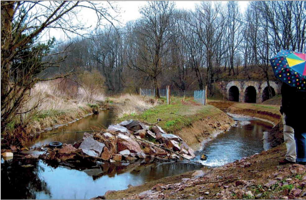
Abb. 5: Im Jahr 2005 angelegter Abzweig des renaturierten Bachlaufes (rechts) vom begradigten Abschnitt der Blauen Flut (Foto: K. Ebeling, April 2006, Untere Wasserbehörde Landkreis Altenburger Land).
