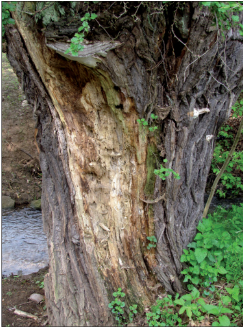
Abb. 25: Von der Weißfäule befallenes Holz hellt auf, die faserige Innenstruktur bleibt noch lange erhalten (Foto: H. Sängner).
