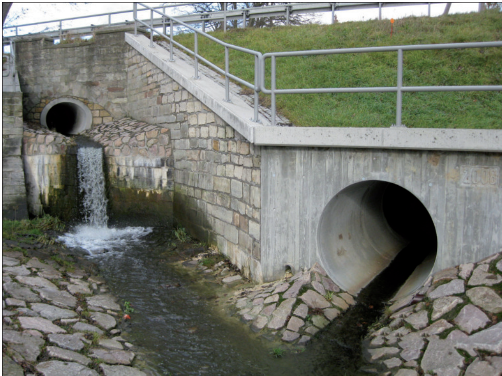
Abb. 5: Unterführung zum Teich in Untschen, die für den Otter nicht nutzbar ist.
