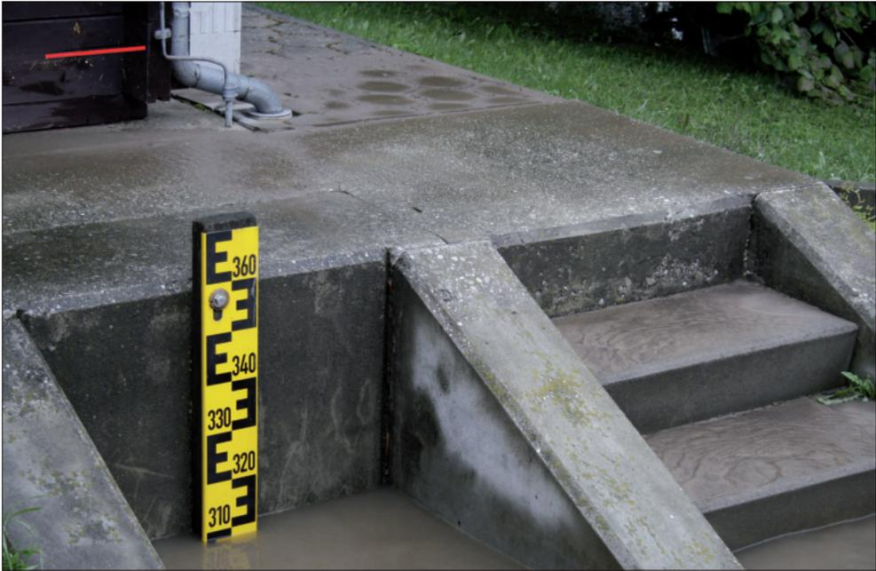
**Abb. 2:** Hochwassermarken am Pegelhäuschen des Hochwassermeldepegels Großstöbnitz. Der rote Balken markiert den Wasserhöchststand (Foto: U. Morgenstern, 03.06.2015, 16.45 Uhr MESZ).
