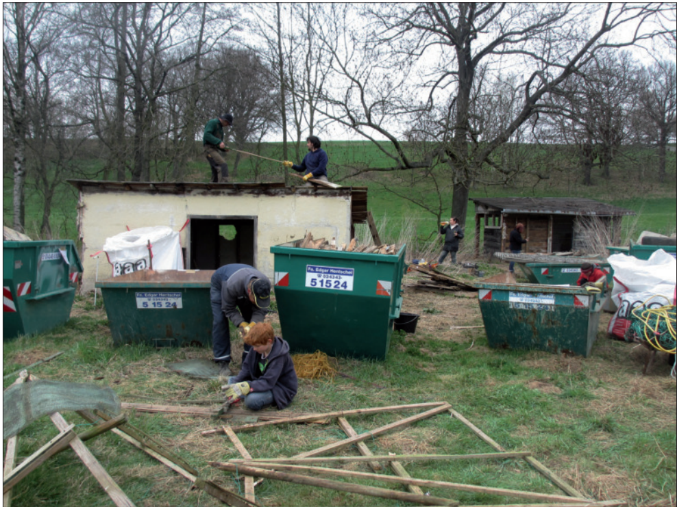
Abb. 19: Abrissarbeiten auf der Projektfläche Papiermühle I durch freiwillige Helfer (Foto: E. Endtmann, April 2013).
