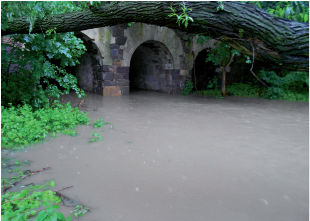
Abb. 3: Beginnende Hochwassersituation auf den Rasephaser Wiesen. Die Blauen Flut trat im Bereich des nördlichen Viadukts weitläufig über das Ufer (Foto: S. Krautz, 02.06.2015).
