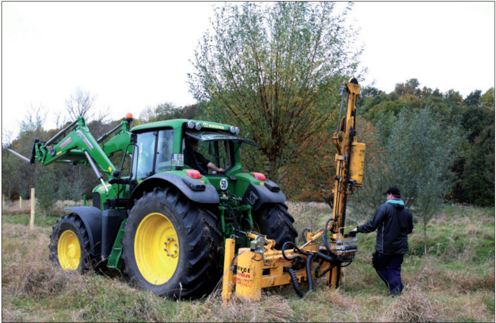
Abb. 21: Einrammen der Robinienpfähle für die Weidezaunanlage auf den Rasephaser Wiesen (Foto: E. Endtmann, November 2012).
