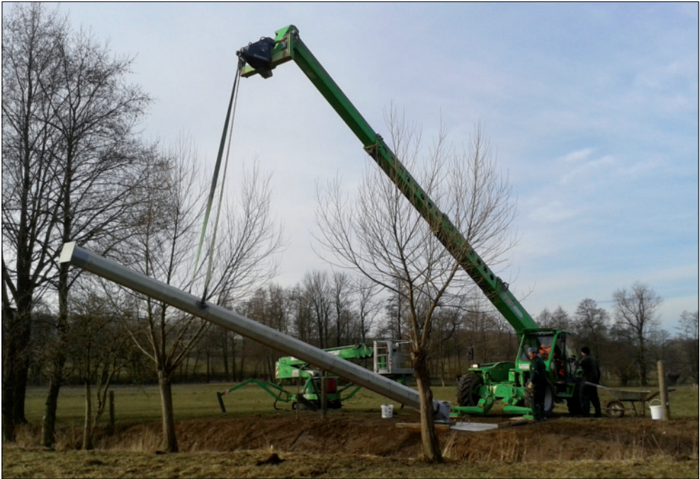
Abb. 47: Aufrichten des ca. 9 m hohen Mastes in Schloßbig (Foto: G. Baumkötter, März 2015).
