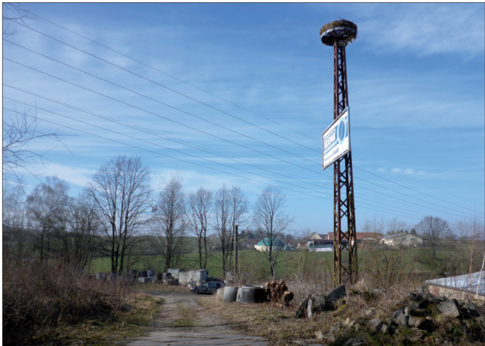
Abb. 46: Freigestellte und ausgebesserte Nistplattform am ehemaligen Betonwerk in Posa (Foto: E. Endtmann, Februar 2014).
