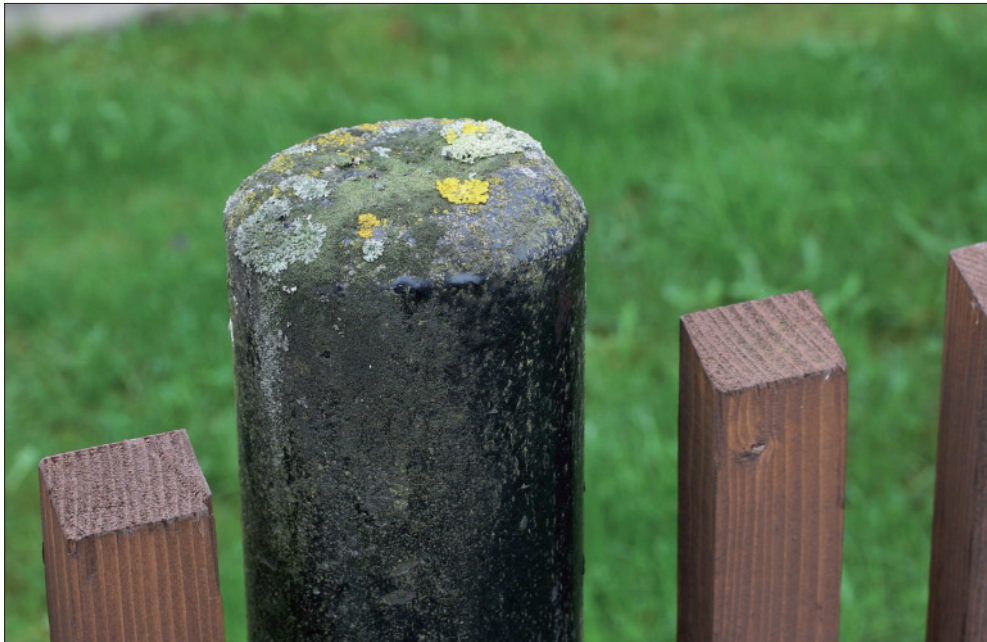
Abb. 6: Mit Beton ausgegossener und überstrichener Eisenpfosten als flechtenreicher Sonderstandort in Unterlödla.
