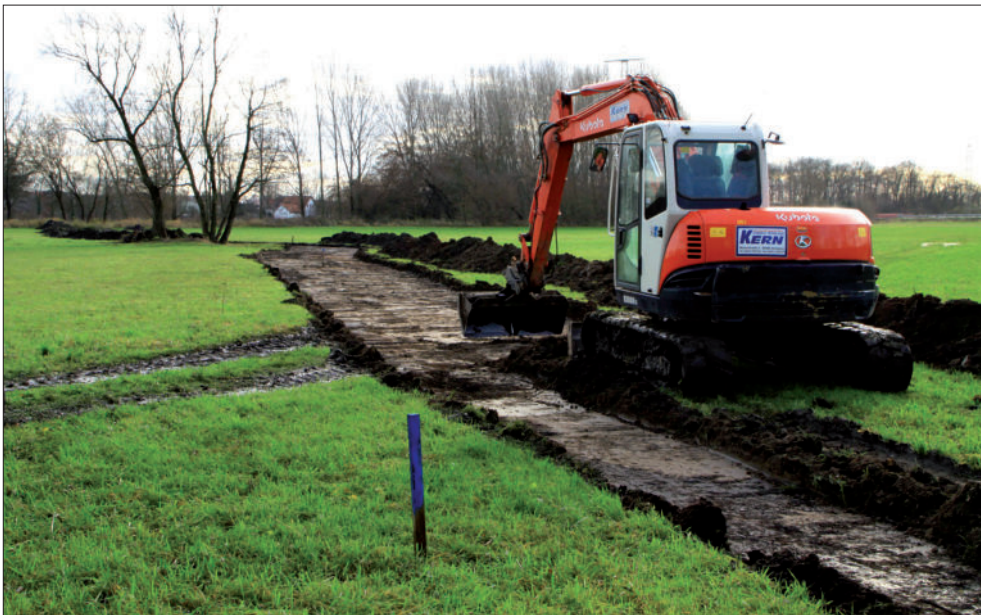
Abb. 21: Beginn der Grabenfreilegung durch Bergung des wertvollen Oberbodens (Foto: Mauritianum).
