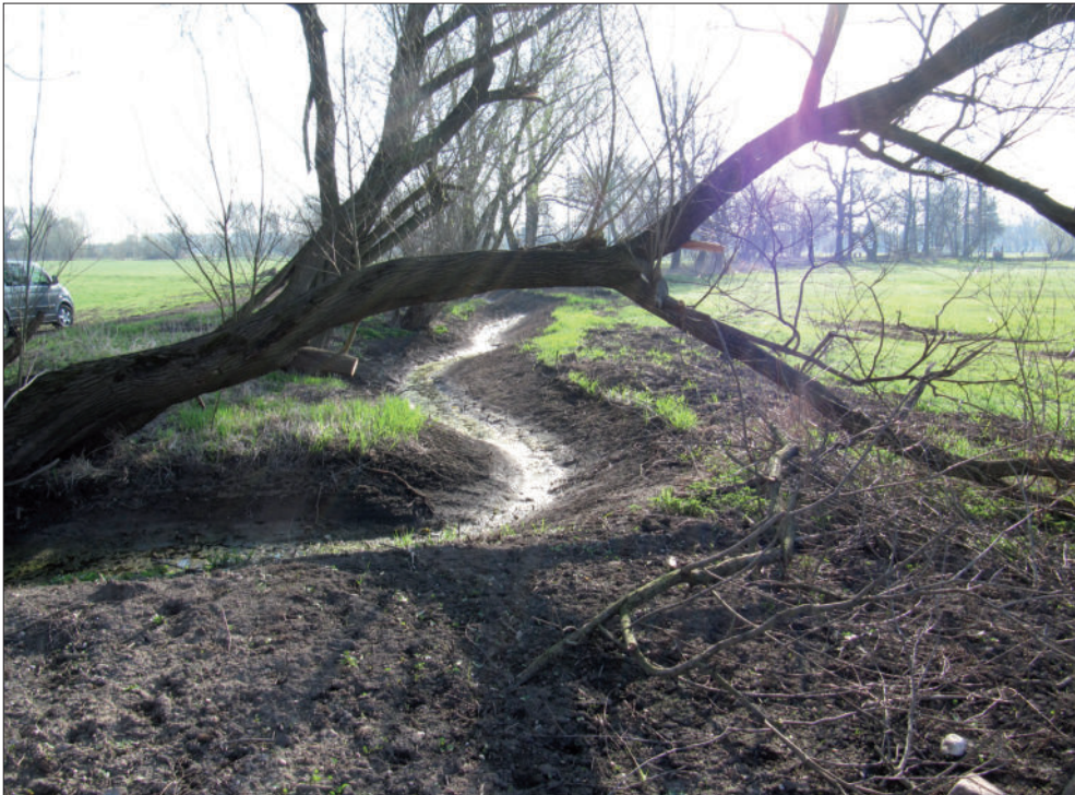
Abb. 22: Grabenprofilierung unter Schonung des wertvollen Baumbestandes (Foto: Mauritianum).
