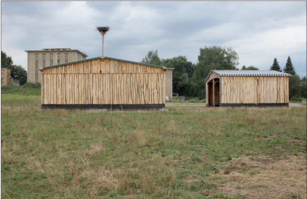
Abb. 13: Die zwei neu gebauten Offenställe auf den Pleißewiesen bieten den Büffeln bei starkem Frost und Wind Schutz (Foto: E. Endtmann).
