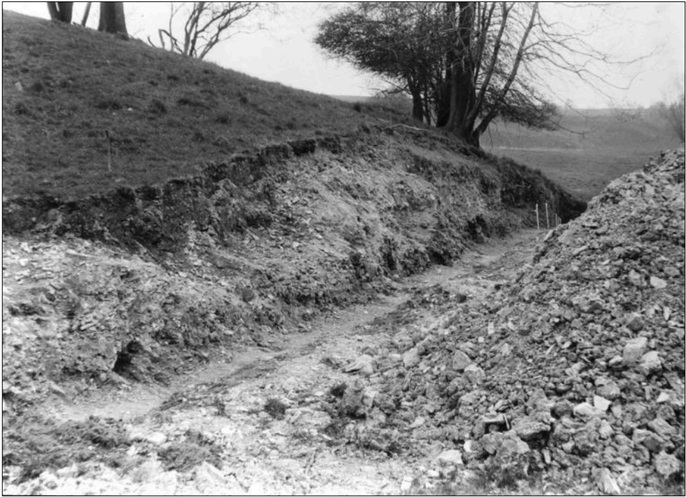
Abb. 2: Zustand der Schürfstelle am Fossilfundpunkt 1990 im Zuge erster studentischer Qualifizierungsarbeiten.
