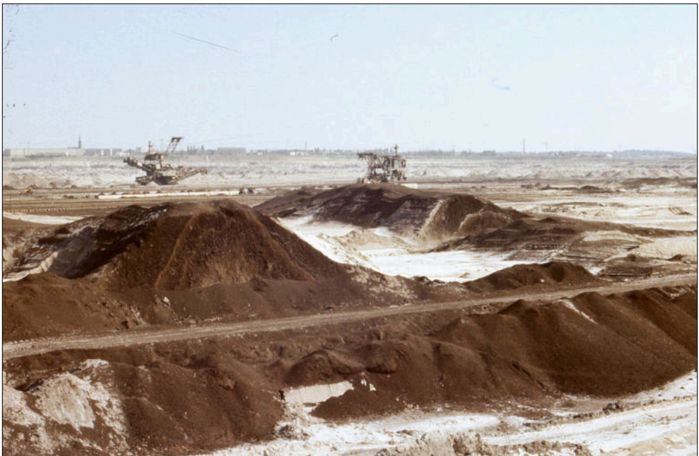
Abbn. 13 (oben), 14 (unten): Typische Braunkohlendiapire im Bitterfelder Flöz (Oberbank I) aus dem ehemaligen Tagebau Golpa-Nord bei Gräfenhainichen. Unter der Auflast schwerer frühpleistozäner Kiese (Dichte ca. 2 \text{ g/cm}^3 ) stieg in einer mobilen Phase die Braunkohle (Dichte ca. 1,15 \text{ g/cm}^3 ) und zum Teil auch der Liegendton bis in das Niveau der elstereiszeitlichen Sedimentfolge auf. Die Randsenken der Diapire sind mit frühpleistozänen Kiesen und mitunter auch mit Erosionsresten der unteren Elstergrundmoräne gefüllt. (Tagebau Golpa-Nord, 1986).
