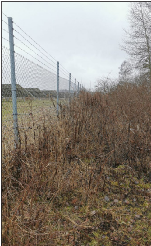
Abbn. 136 und 137: Vierzügiger Elektrozaun mit Abstandshaltern am Maschendrahtzaun der Solaranlage vor und nach dem Freistellen von Vegetation, 08.02.2024 und 21.01.2022. (Fotos: S. Rockstroh)
