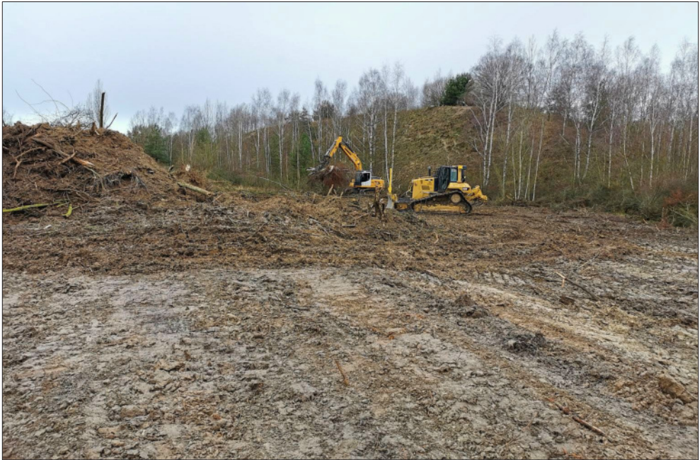
Abb. 6: Gehölzentnahme von Sukzessionsflächen und Wiederherstellen von Rohböden mit Planierdrape und Kettenbagger auf dem trockenen Mittelkippenplateau, 26.02.2020. (Foto: S. Rockstroh)
