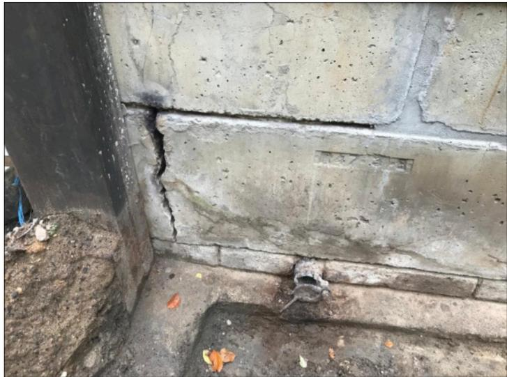
**Abb. 3:** Durch Vernässung entstandene Schäden am Mauerwerk und Fundament eines Produktionsofens der Köhlerei Eisenhammer (Foto R. Zenger)
