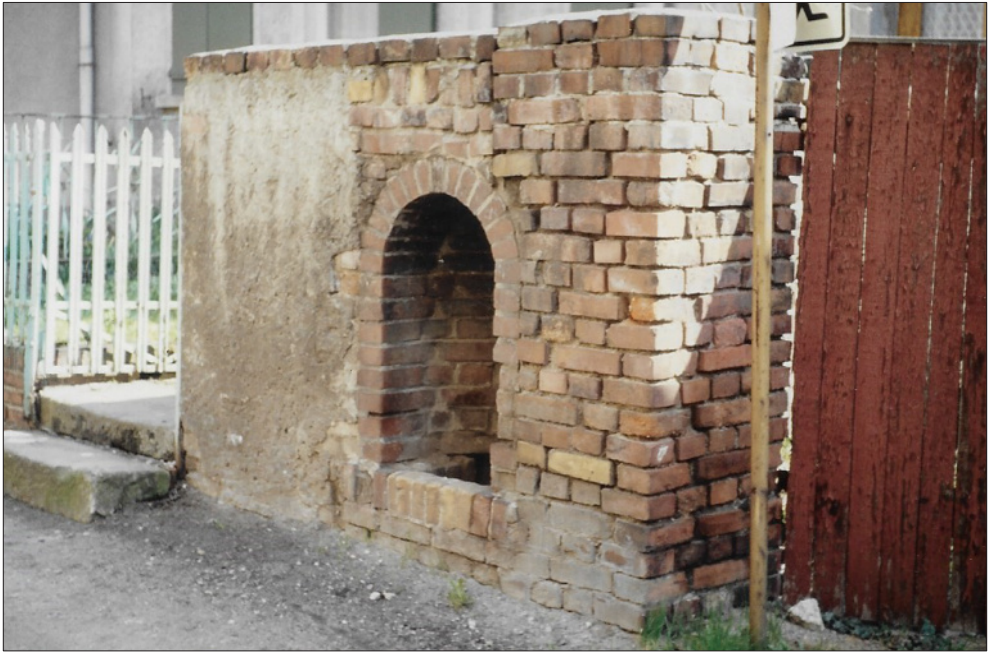
Abb. 2: Baustil der meisten artesischen Brunnen in Bad Dübau mit typischer Nischenform (eingelassene Halbmondnische) in einem aus Ziegelstein errichtetem Quader. (Foto: R. Zenger)
