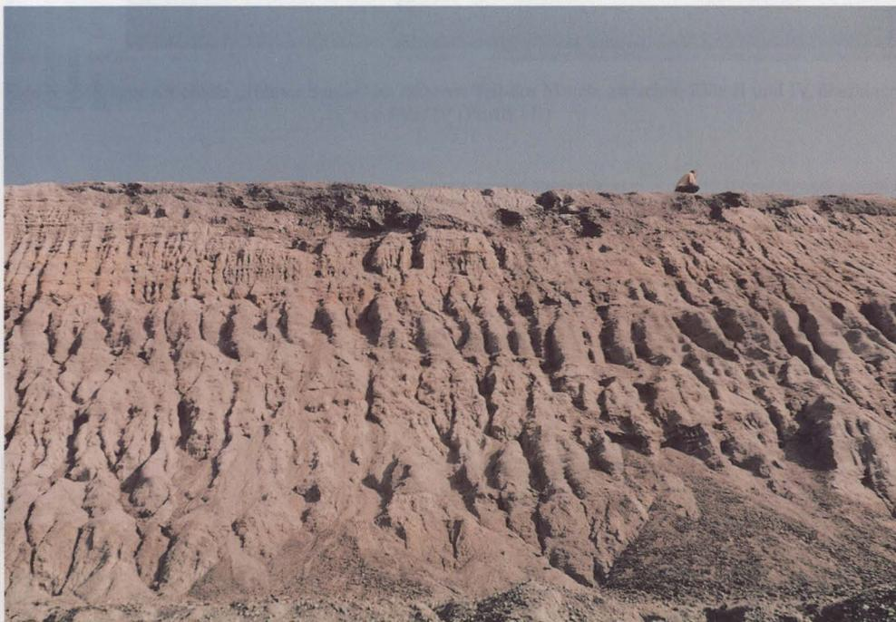
Foto 2. Tagebau Bockwitz, Ostböschung, 1994, „Thierbacher Schichten“ mit zahlreichen Erosionsrinnen
